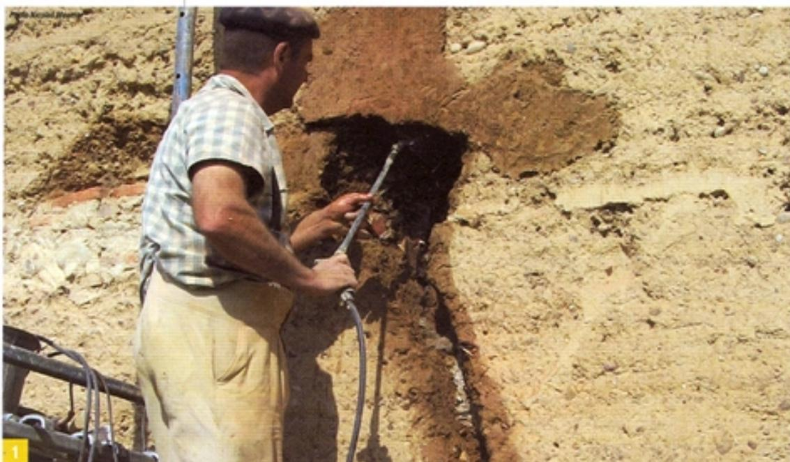
1 Purge d'une partie d'un mur en pisé, avec légère humidification avant réparation.
