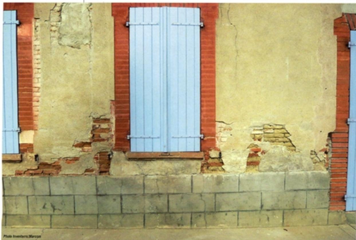
Décollement d'enduit sur un mur monté en adobes et briques de terre cuite.
