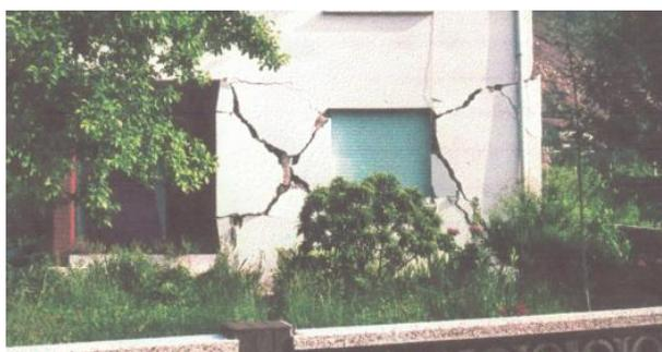
FIG. 2.10 – Exemple de fissures entre ouvertures trop proches
