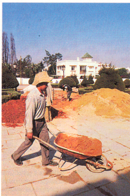
Universalité de la construction en terre. Ici : un chantier de restauration à Rabat (Maroc).
