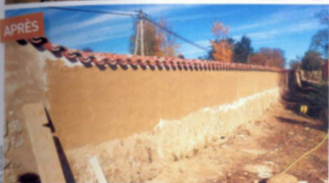
Deux techniques sont acceptées pour les renformis : de préférence avec un matériau et une technique proches de celle du mur, sinon, avec un matériau proche de l'enduit.
